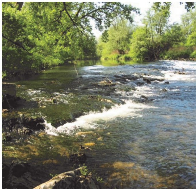
Stanje na pragu pred začetkom rekonstrukcije, na sliki so vidne vrzeli in premaknjene skale, ki jih je odneslo dolvodno
