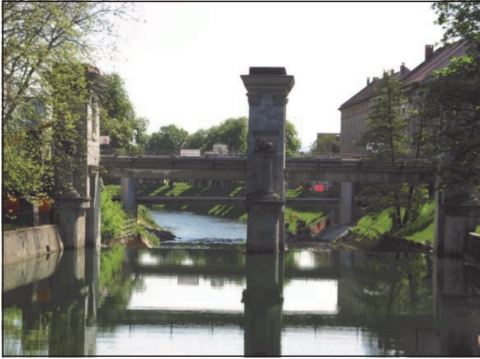
Zapornica na Ambroževem trgu - gorvodna stran
