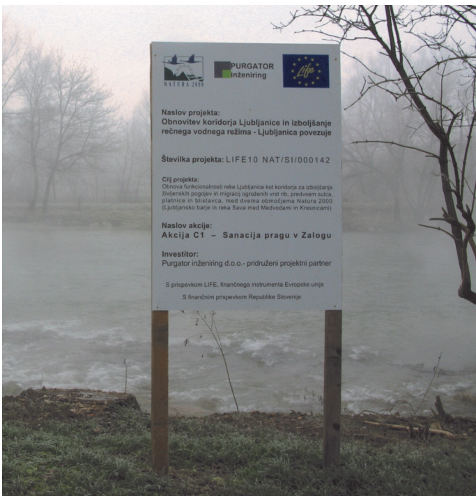
Gradbiščna tabla na pragu v Zalogu
