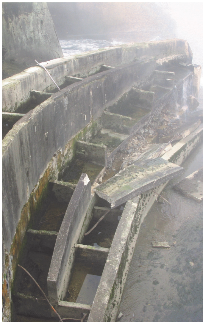
Ribja steza na Fužinskem jezu pred (levo) in po (desno) obilnem jesenskem deževju, ki je povzročilo poškodbe
