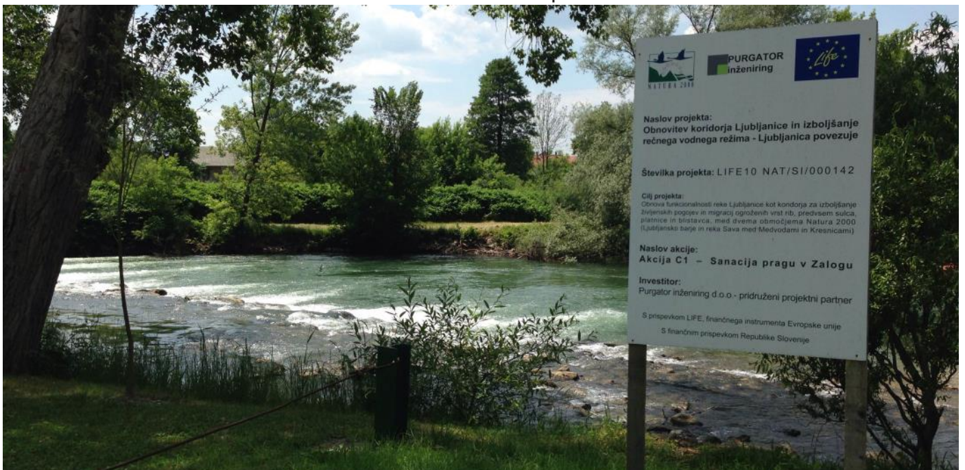
Obnovljen prag v Zalogu
