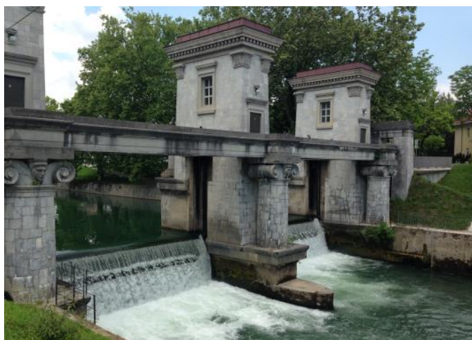
Zapornice na Ambroževem trgu
