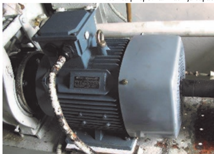
Dotrajan motor pred obnovo (levo) in nov motor (desno), ki omogoča tudi manjše premike zapornice
