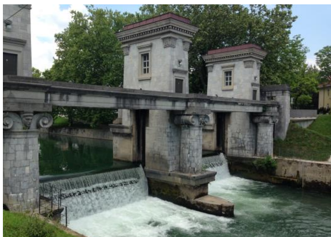
Zapornice na Ambroževem trgu
