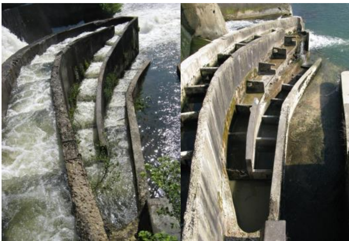
Ribja steza na Fužinah pred porušitvijo in po porušitvi jeseni 2013
