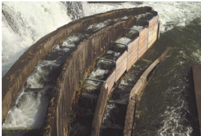
Obnovljen del porušene steze na Fužinah
