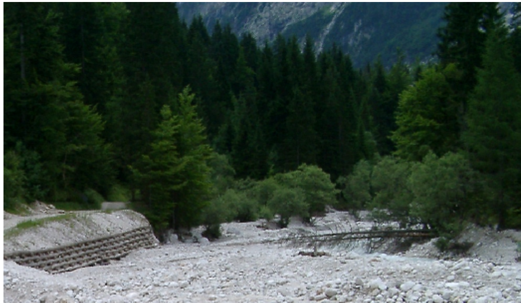
Primer nevzdrževanega vodotoka (avtorska slika)
