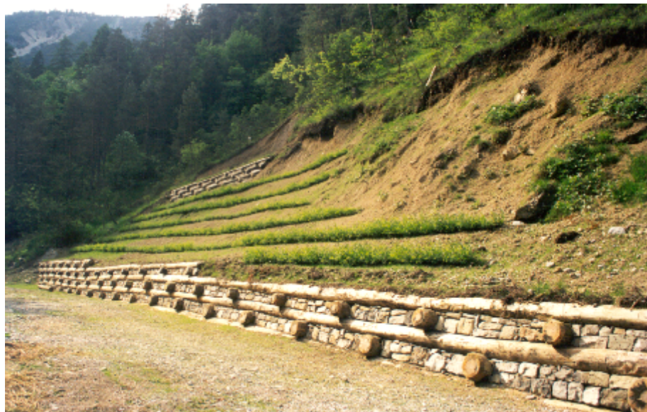
Kombinacija različnih inženirsko bioloških metod stabilizacije (Vir: Progetto F.R.A.N.E. , 2005)
