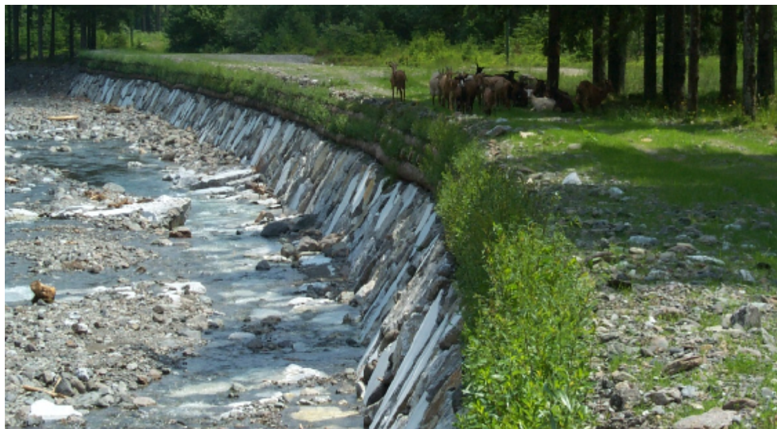
Kombinacija klasične ureditve na peti brežine, nad njo sonaravna utrditev brežine vodotoka (Vir: Progetto F.R.A.N.E., 2005)
