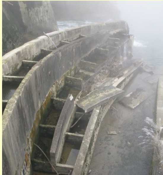
Ribja steza na Fužinah pred in po poškodbi
