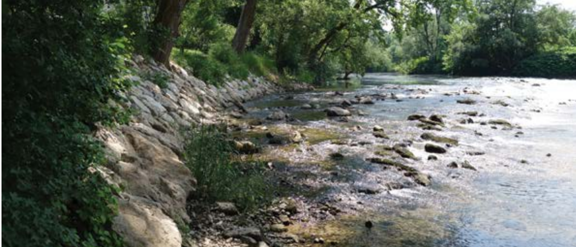
Slika 7: Saniran prag nizvodno od mrtvice v Zalogu in utrjena brežina (foto: A. Vihar)
