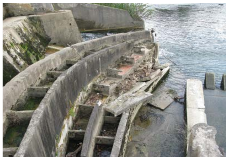
Slika 2: Porušena stena in nedelujoča ribja steza pri Fužinskem jezu pred obnovo (levo) in izvedeni ukrepi obnove porušene stene (desno) (foto: M. Sečnik)
