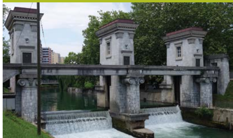
Slika 5: Zapornice na Ambroževem trgu (foto: K. Sapač)
