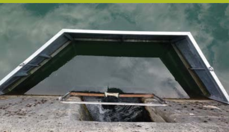
Slika 3: Izhod iz ribje steze na Ambroževem trgu pred obnovo (zgoraj) in po obnovi (spodaj) z nameščenim deflektorjem za zadrževanje plavja (foto: M. Sečnik, A. Vihar)
