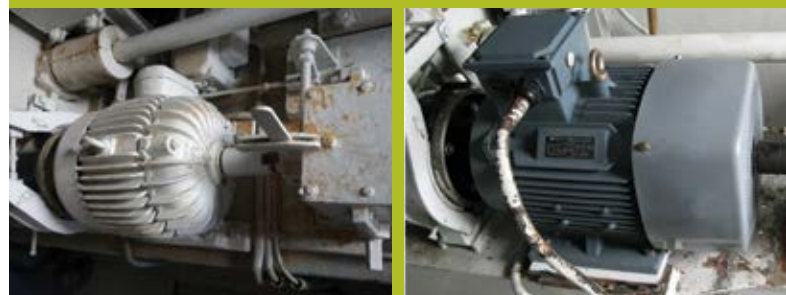
Slika 6: Prejšnji, dotrajani motor (levo) in nov, zamenjan motor (desno) za reguliranje zapornic na Ambroževem trgu (foto: M. Sečnik, A. Vihar)
