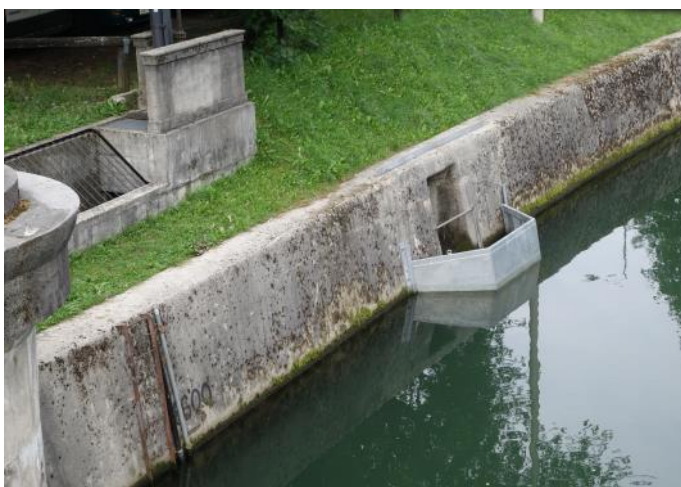
Element, ki preprečuje vnos plavja v ribjo stezo
