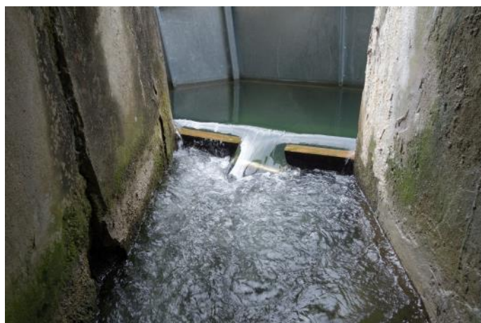
Dodatna stopnica s prelivom na vtoku v stezo, namenjena reguliranju pretoka skozi ribjo stezo
