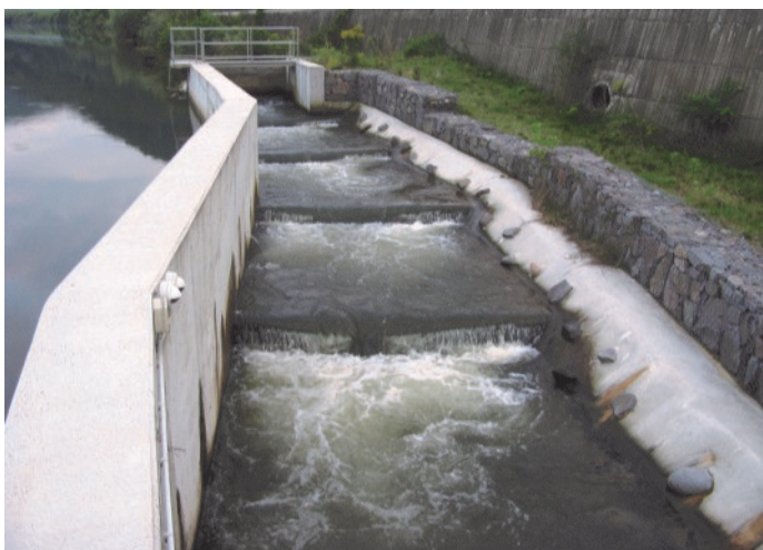
Ribja steza na mali hidroelektrarni Hronská Dúbrava
