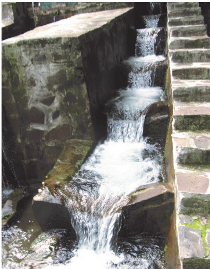
Ribja steza na mali hidroelektrarni
