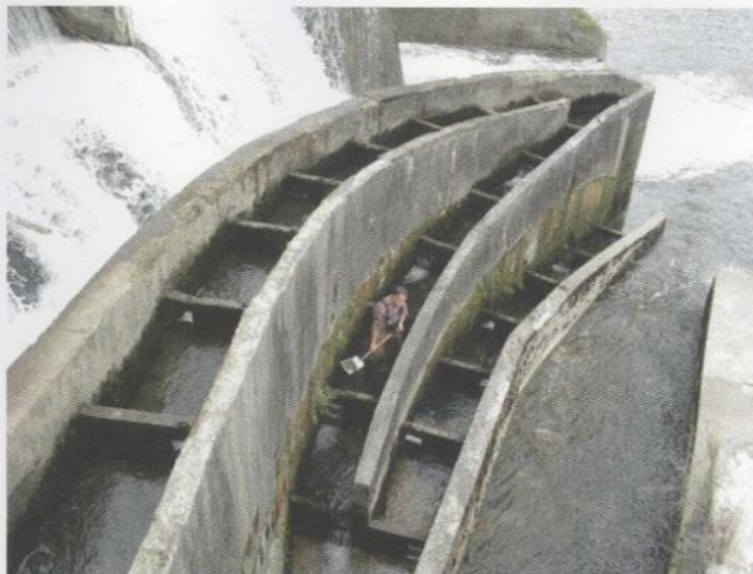
Slika 4: vzdrževalna dela na ribji stezi pred neurjem
