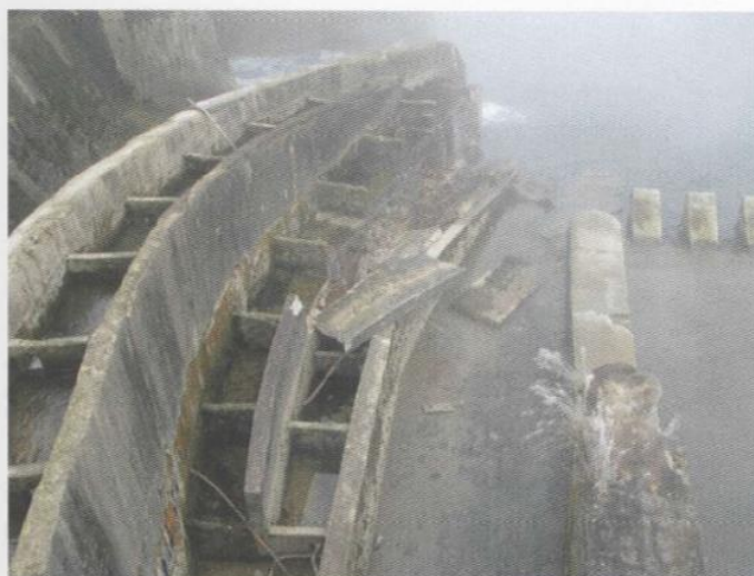
Slika 5: porušitev sten ribje steze po neurju
