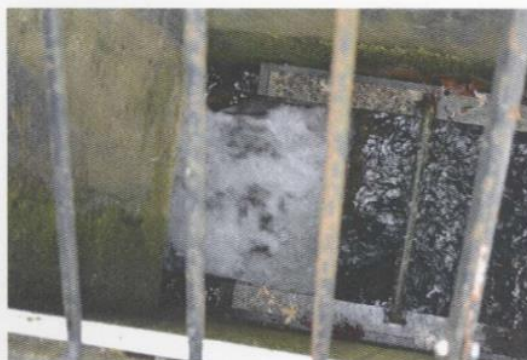
Slika 2: Deroči tok vode pri prelivanju preko praga v dnu steze na iztoku iz nagibnega žleba
