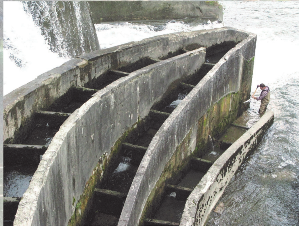
Obnova ribjega prehoda ob Fužinskem jezu
