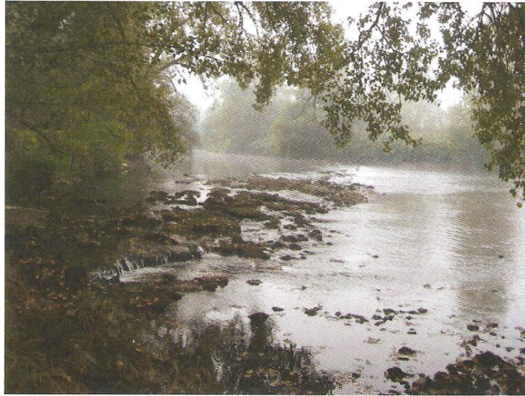
Slika 2: prag v Zalogu pred posegom – vidne poškodbe ob levi brežini
