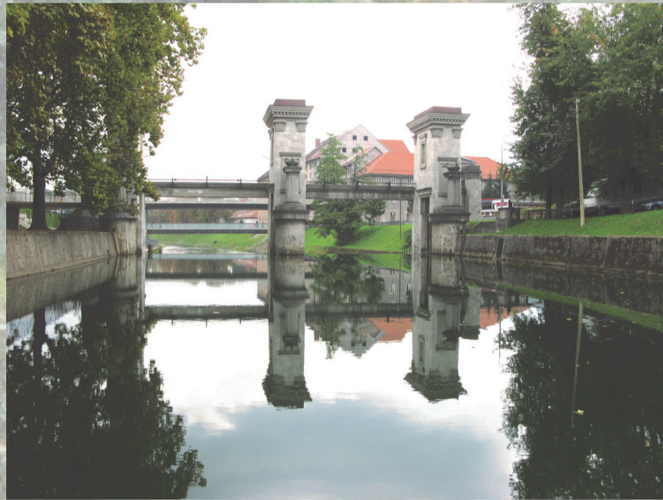
Posodobitev sistema zapornic in ribjega prehoda pri Ambroževem trgu
