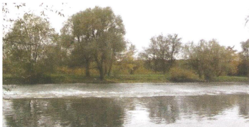
Slika 4: prag v Zalogu po sanaciji
